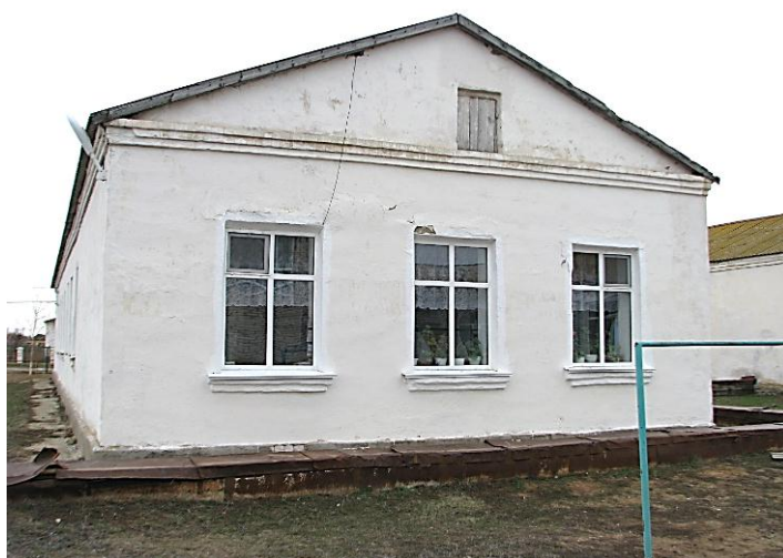
Фото 3. Фасад в осях А-В/5. Общий вид.
