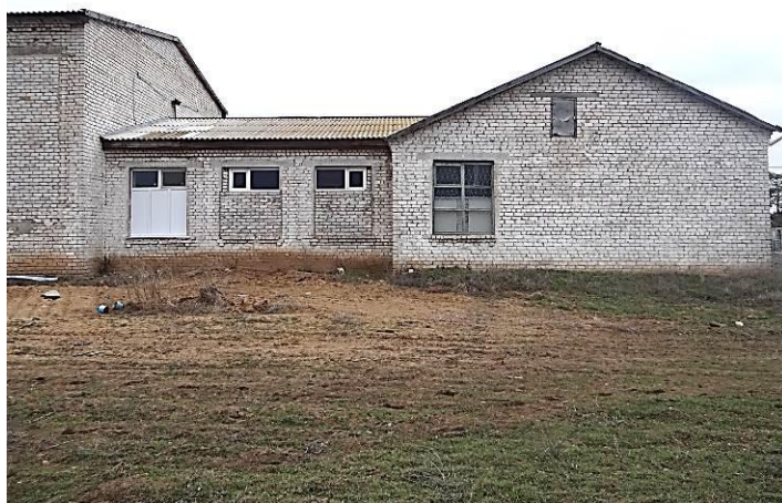
Фото 6. Фасад в осях Г-И/11-12. Общий вид.
