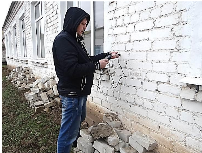
Фото 9. Определение прочности кирпичной кладки
