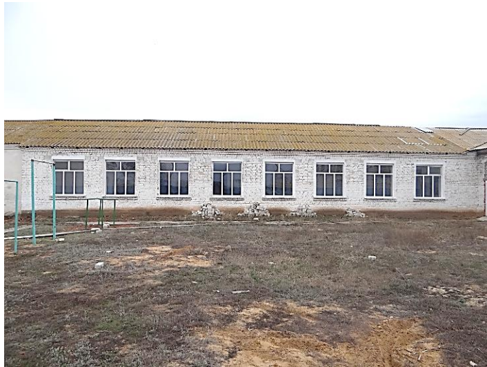
Фото 4. Фасад в осях Д/6-9. Общий вид.
