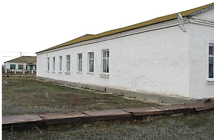
Фото 2. Фасад в осях А/1-5. Общий вид.
