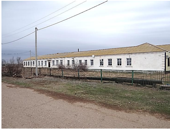
Фото 7. Фасад в осях И/12-1. Общий вид.
