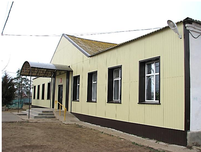
Фото 1. Фасад в осях И-А/1. Общий вид.
