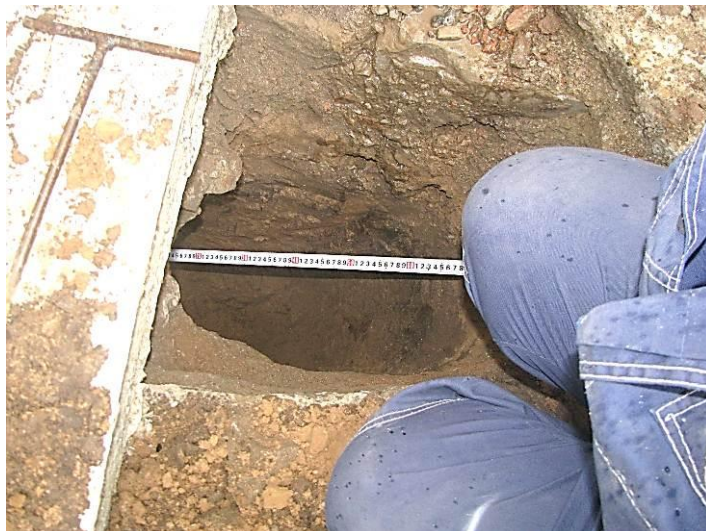
Фото 9. Проведение обмерных работ в месте проходки шурфа
